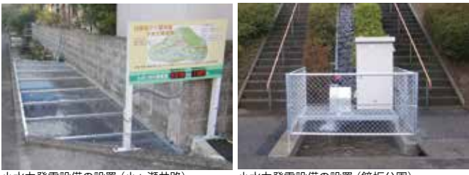
小水力発電設備の設置（小ヶ瀬井路） 小水力発電設備の設置（鏡坂公園）
